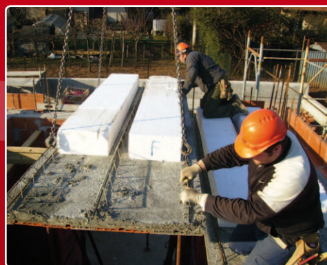
4 POSA IN CANTIERE
